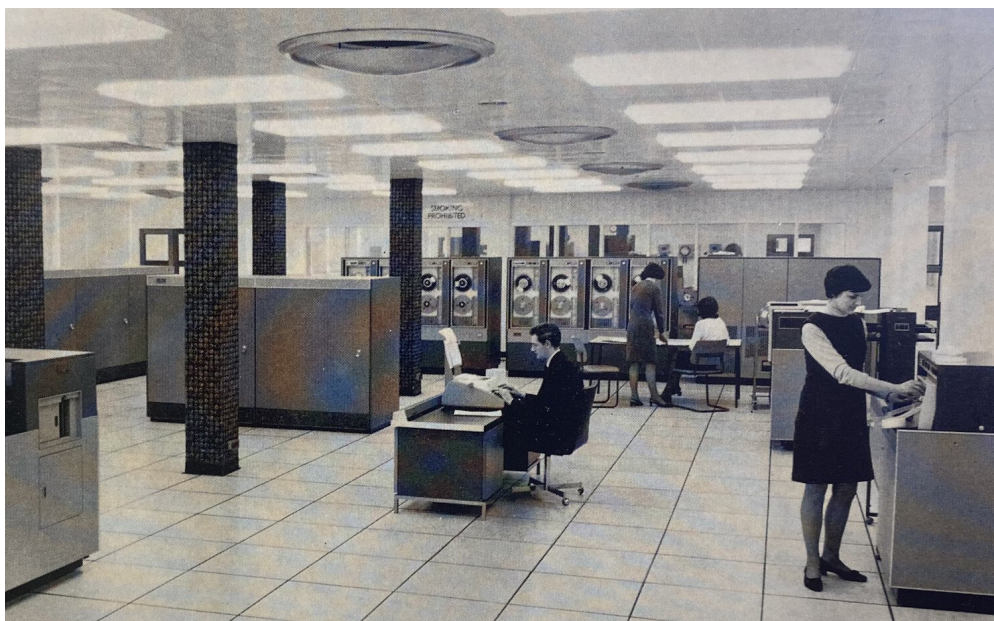
Fig. 22 – Partie d'une configuration informatique ICT 1906 : un lecteur-poinçon est à gauche, un lecteur de bandes de papier à droite et les lecteurs de bandes magnétiques sont visibles derrière la console de la machine à écrire.
